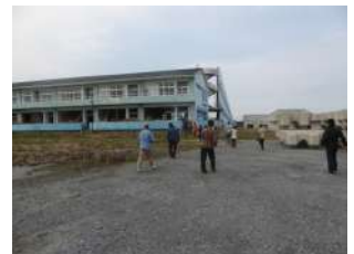
津波により冠水した浪江町立戸小中学校 当時のまま残されている
