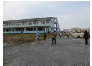
津波により冠水した浪江町立戸戸小学校 当時のまま残されている
